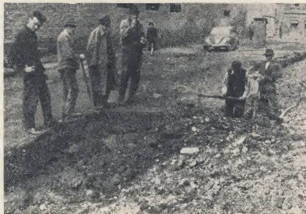
Sl. 2: Iskopi sa prebacivanjem zemlje
